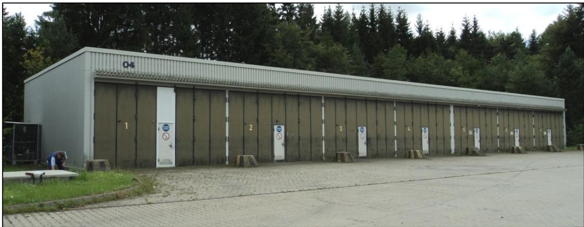
Abb. 41: Instandsetzungshalle O4 (Quelle: Potentialanalyse DAIMLER)
