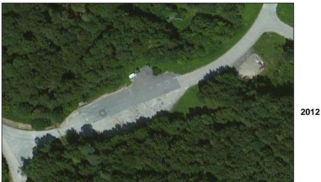
Abb. 24: Die ehemalige Panzerwaschanlage [148, 150, 151] in Luftbildausschnitten von 1986 und 2012. (Quelle: Landesamt für Geoinformation und Landentwicklung Baden-Württemberg [oben]; BING [unten])
