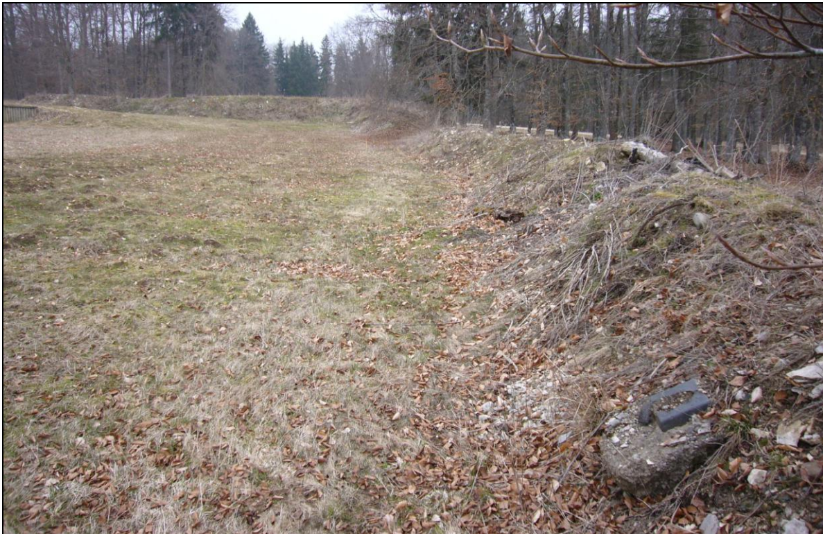
Abb. 32: Schutzwall um den aktuellen Sprengplatz [224]
