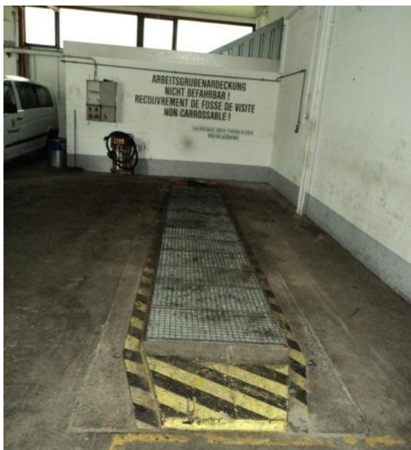
Abb. 40: Innenansicht der Wartungshalle O2 (Quelle: Potentialanalyse DAIMLER)
