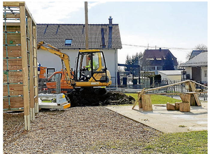
Foto: der Bagger ist da
